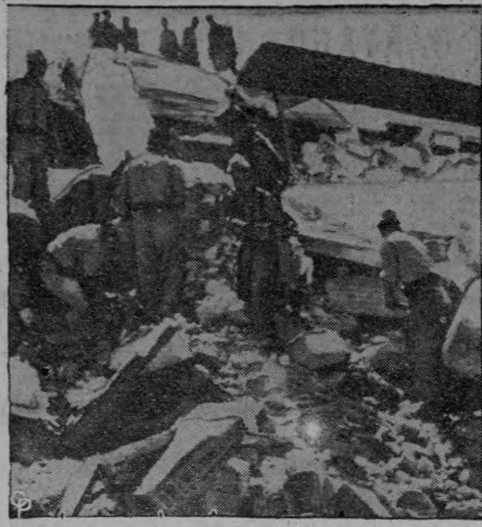
40 MUERTOS EN DESPLOME DE EDIFICIO.— Un equipo de trabajadores de rescate examinan las ruinas de un nuevo edificio de apartamentos de cinco pisos que se desplomó en Barletta, Italia. Los cadáveres de 40 personas, hombres mujeres y niños, han sido rescatados de las ruinas hasta el momento. Trece personas, críticamente heridas, fueron también rescatadas, pero se teme que el número total de muertos pueda elevarse de 60 a 100. —
